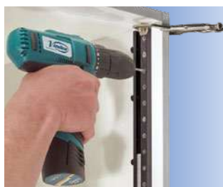
Taladrado para la colocación de estantes.
