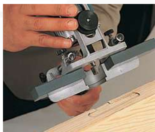
Colocación de pernios con el cabezal ZB93.
