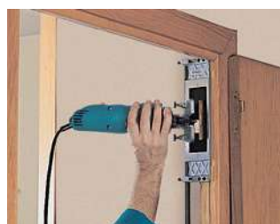
Colocación en el marco (Mod. A093)
