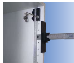
Taladrado para la colocación de bisagras invisibles.
