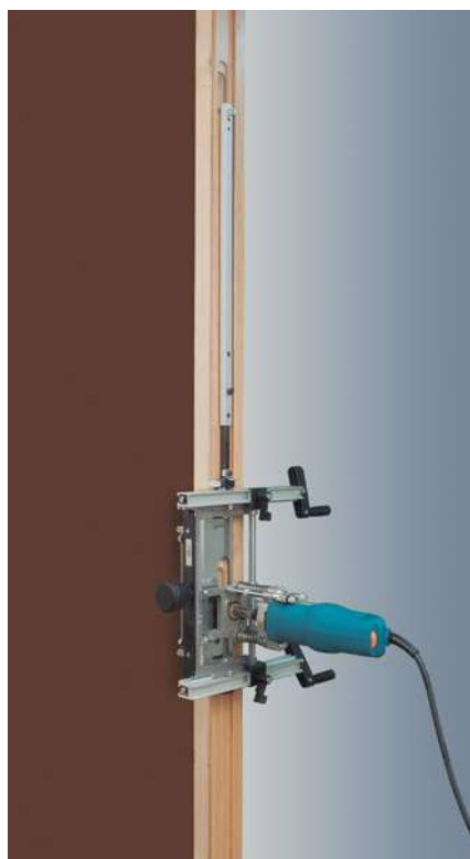
Realización del segundo encaje en el marco.
